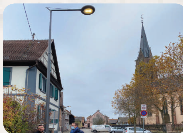
Changement des lampadaires rue du Maréchal Joffre
