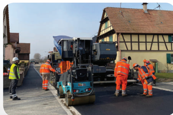
Pose du revêtement de la rue du Maréchal Joffre
