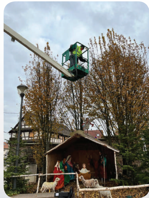
Mise en place des décorations de Noël
