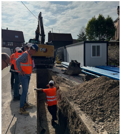
Travaux Grand Rue de l'Eglise
