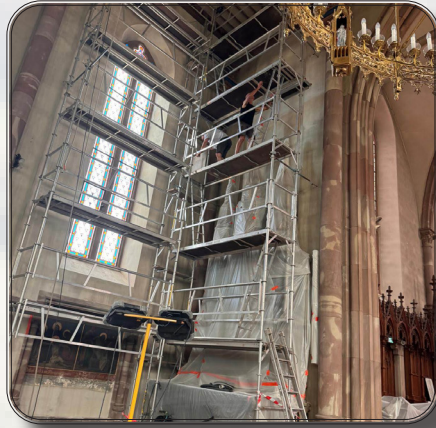
Travaux à l'Eglise
