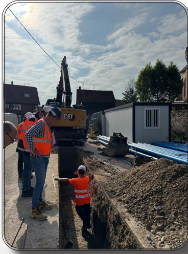
Travaux Grand Rue de l'Eglise
