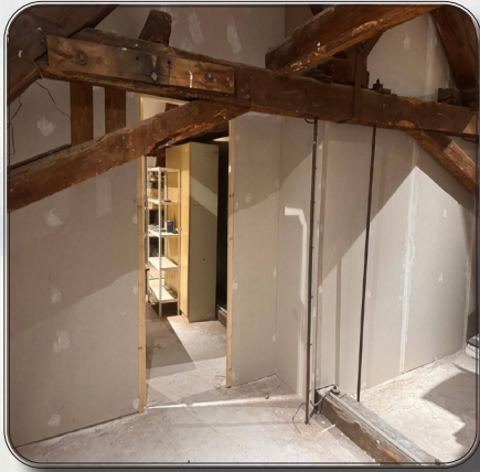
Création d'un local archive
